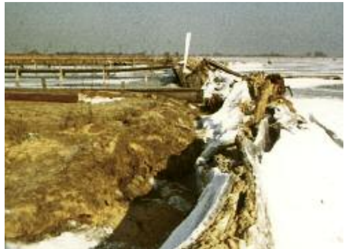
Die eingedrückte Spundwand im Winter 1970
