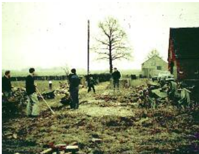
Clubhaus-Baustelle auf dem Grundstück Schmutte
