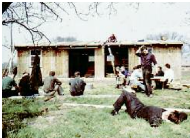
Zusammenbau der Teile des ehemaligen Kindergartens
