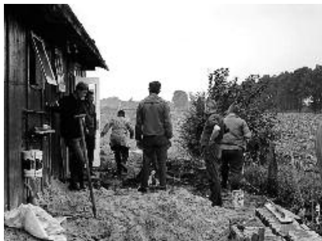
Der rückwärtige Bereich des Clubhauses bei Schmutte während der Bauzeit
