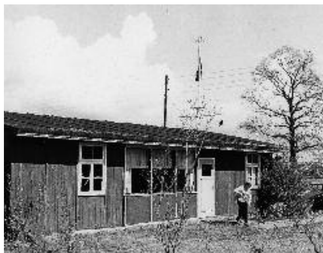
Die fertige Holzbaracke als SCC-Clubhaus
