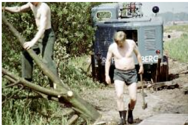
Arbeiten im Hafen an der Deichschleuse (re.: Walter Riedel)
